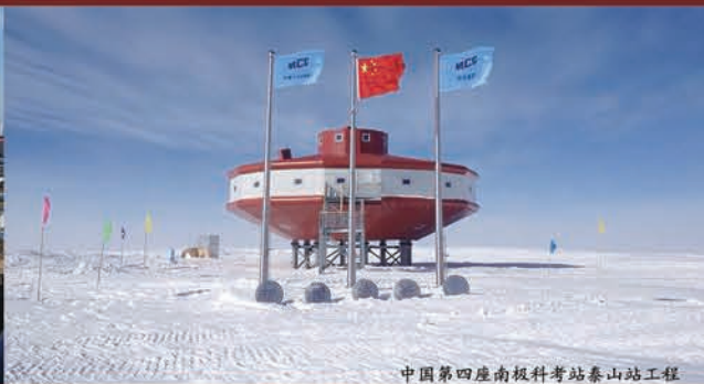
中国第四座南极科考站泰山站工程
